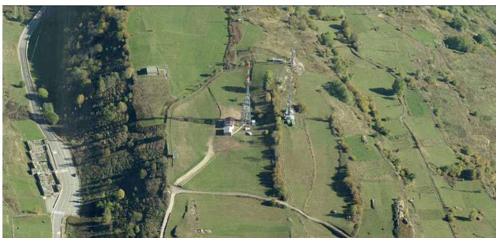
La zona sommitale con le antenne per le telecomunicazioni
