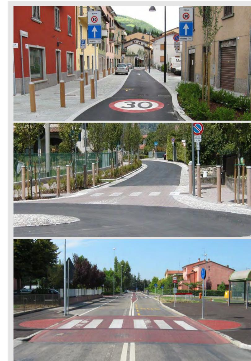
Esempi di interventi per la moderazione del traffico, protezione di pedoni e ciclisti e risoluzione barriere architettoniche.
